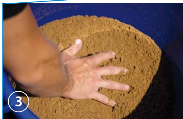
Mieszamy całość, w celu połączenia gliny z odpowiednią ilością wody
